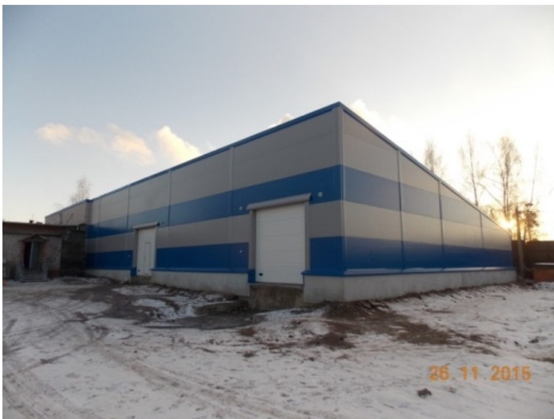
Теплый склад, г. Ярославль, 2015 год
