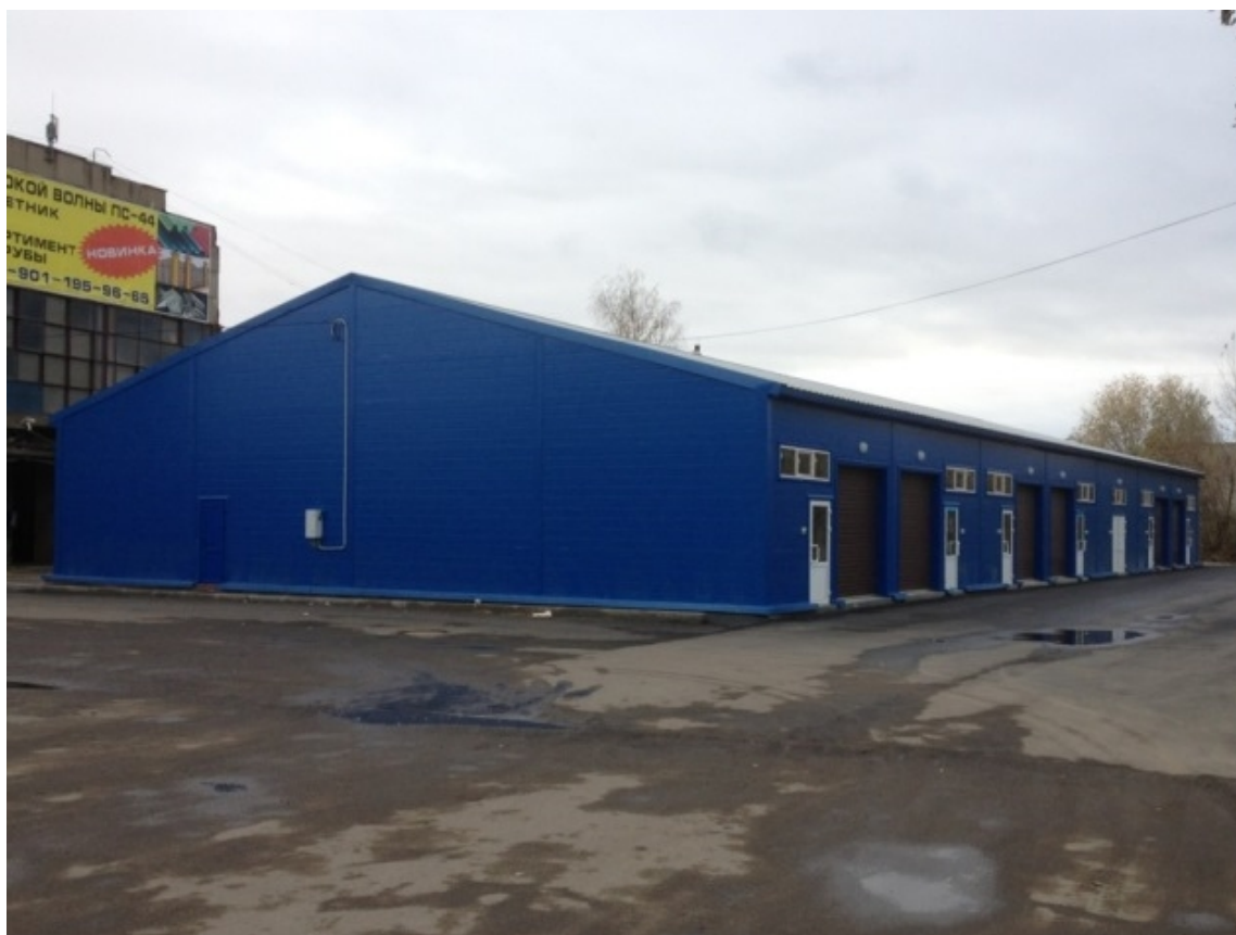
Складское здание, г. Рыбинск, 2015 год
