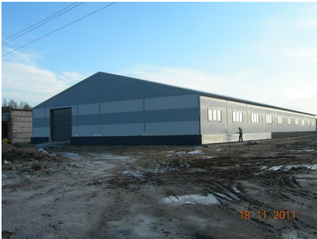
Производственное здание, Ярославская область, г. Рыбинск, 2011 год
