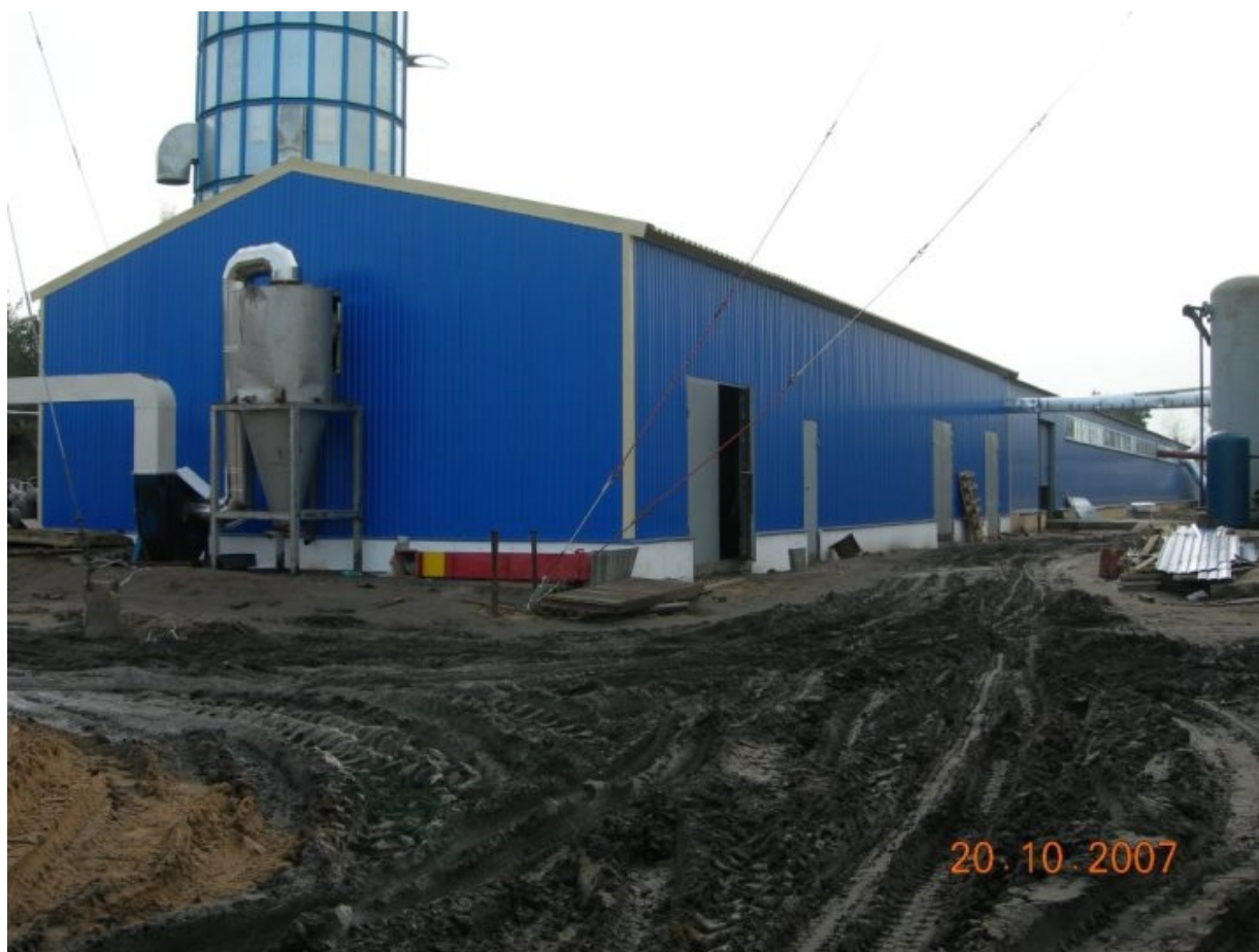
Котельная, г. Углич, 2007 год
