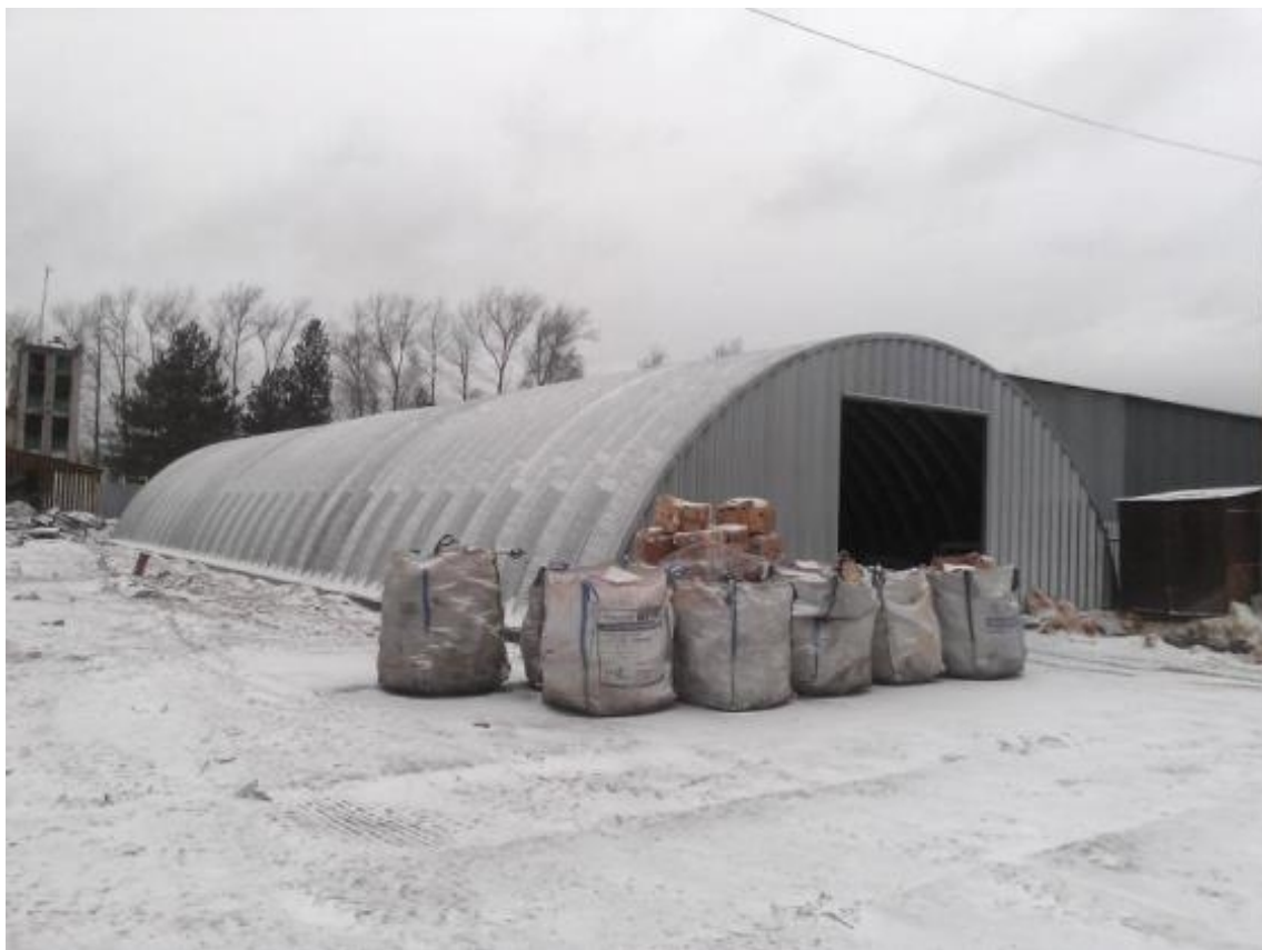
Холодный склад, Костромская обл., г. Нерехта, 2014 год
