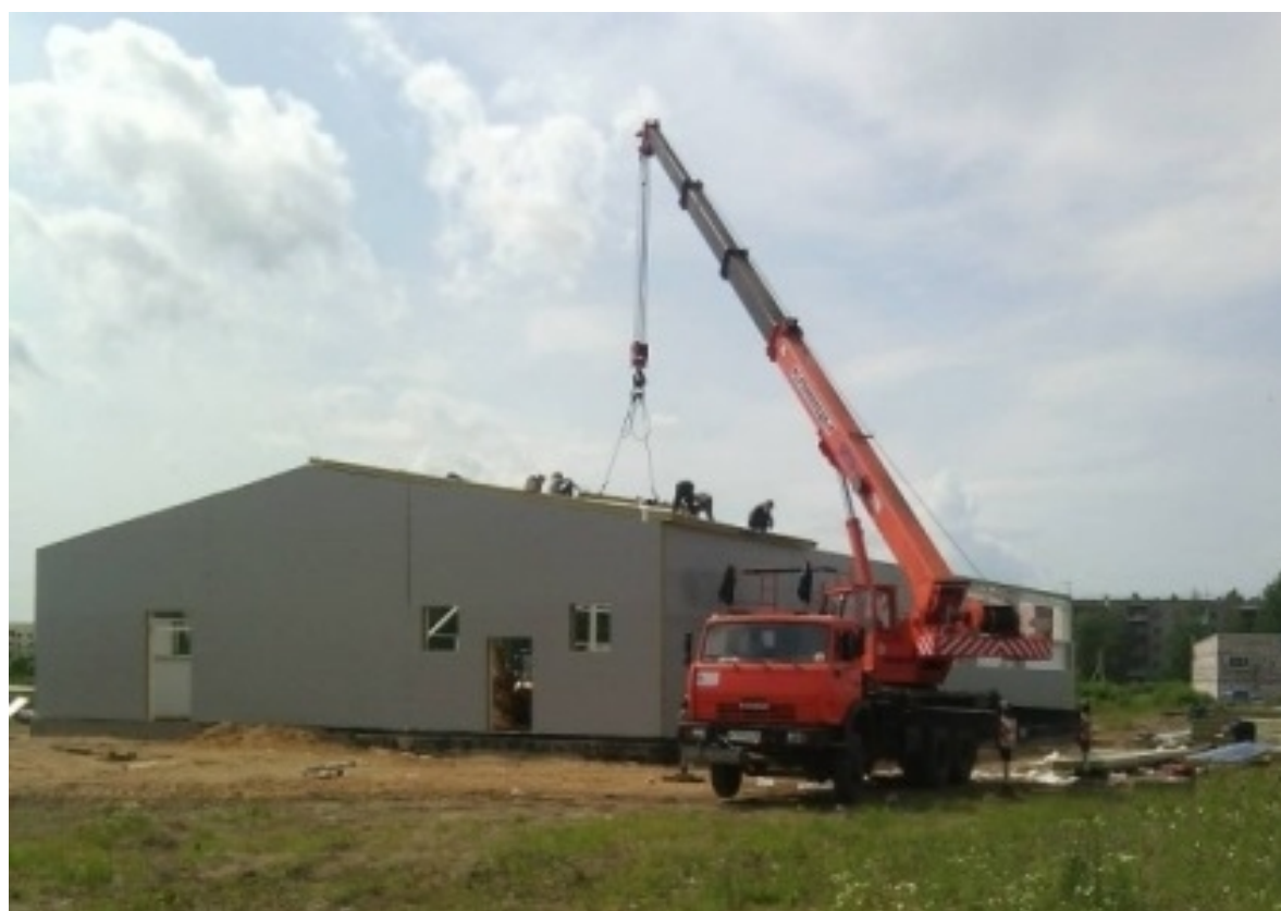
Теплый склад, Ярославская обл., г. Ростов, 2014г.
