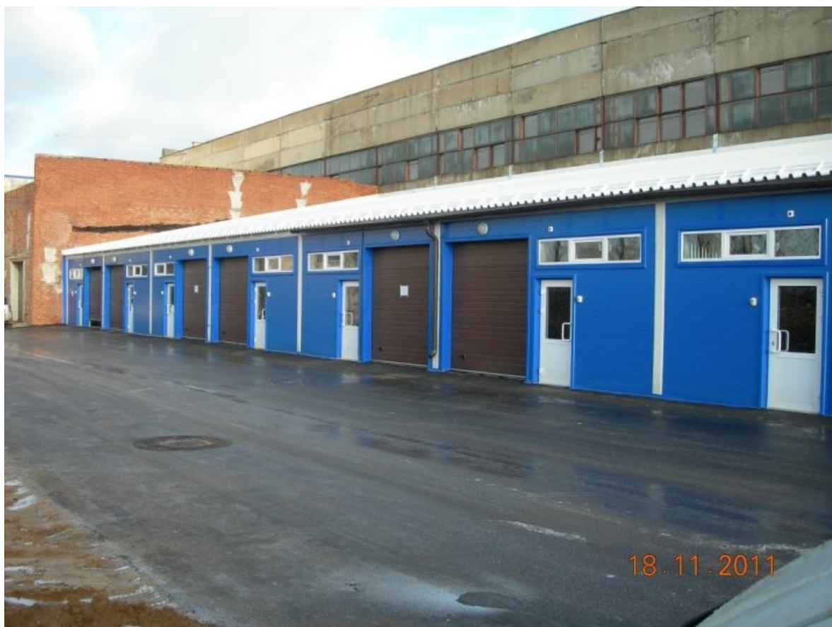
Складское здание, г. Рыбинск, 2011 год
