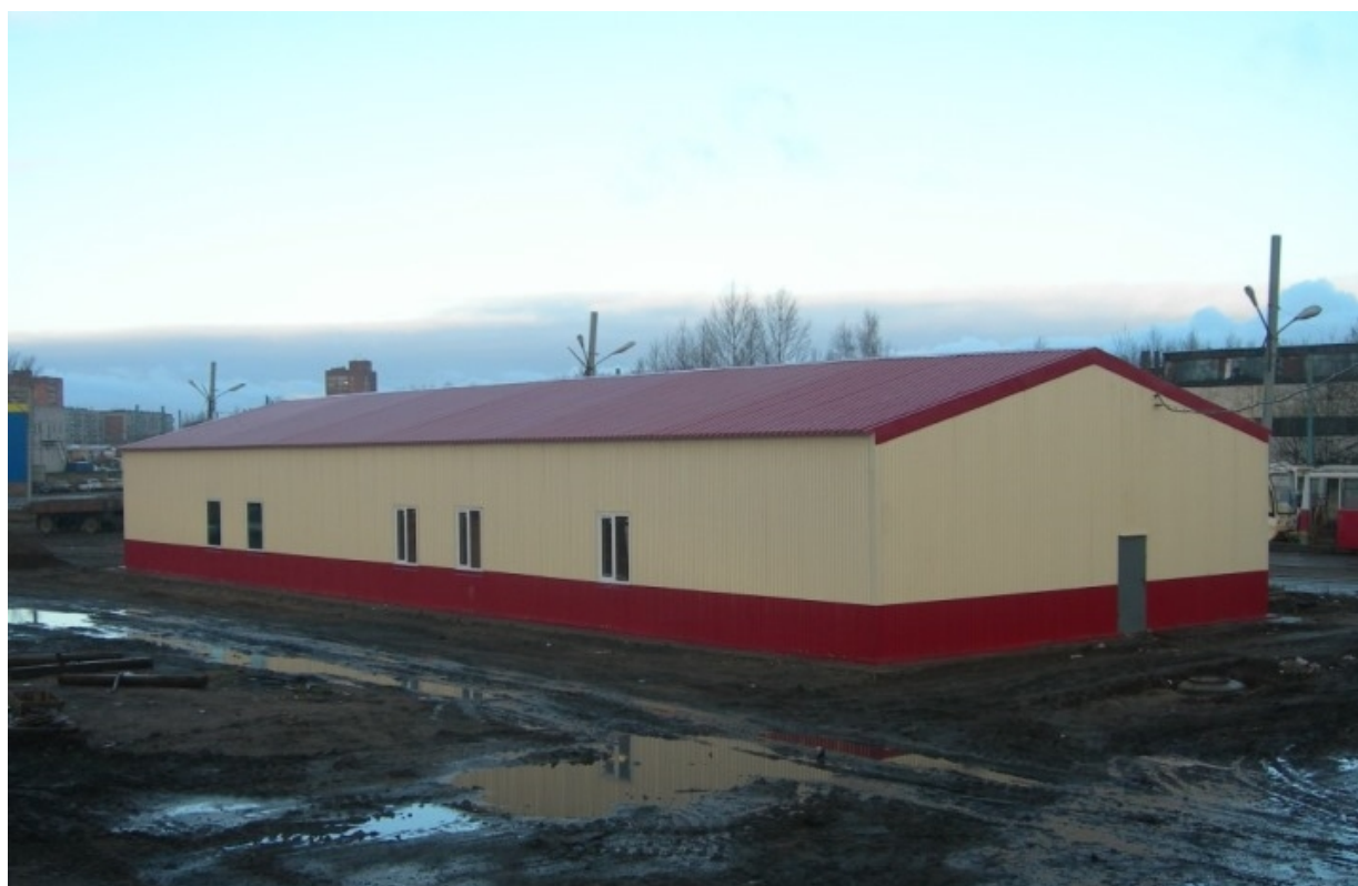
Ремонтные мастерские, г. Ярославль, 2006 год
